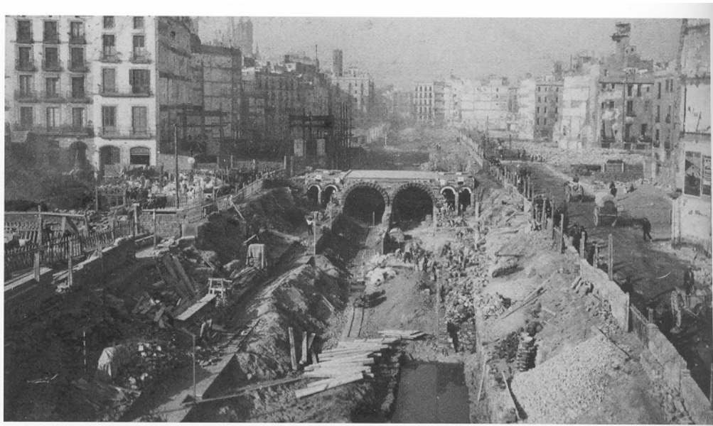
Tunels del futur metro, Via Laietana. (Museu d'Història de la Ciutat)
